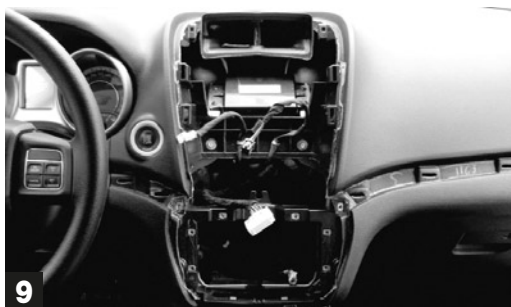
9 Come si presenta la plancia con tutti i componenti rimossi. How the location looks like, when all components have been removed.
